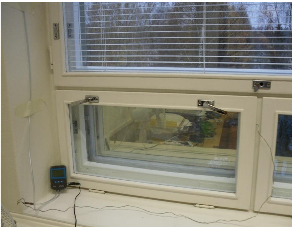
KUVA 2. Paine-eromittaus ulkovaipan yli tuuletusikkunan kautta. Valokuva Timo Tikkanen 2013
